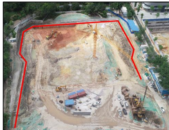
基坑顶截水沟
