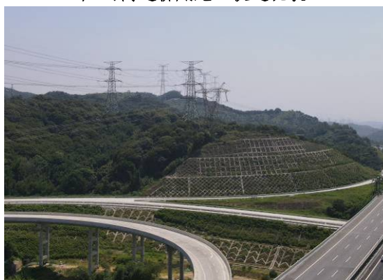
路基挖填方边坡防护
