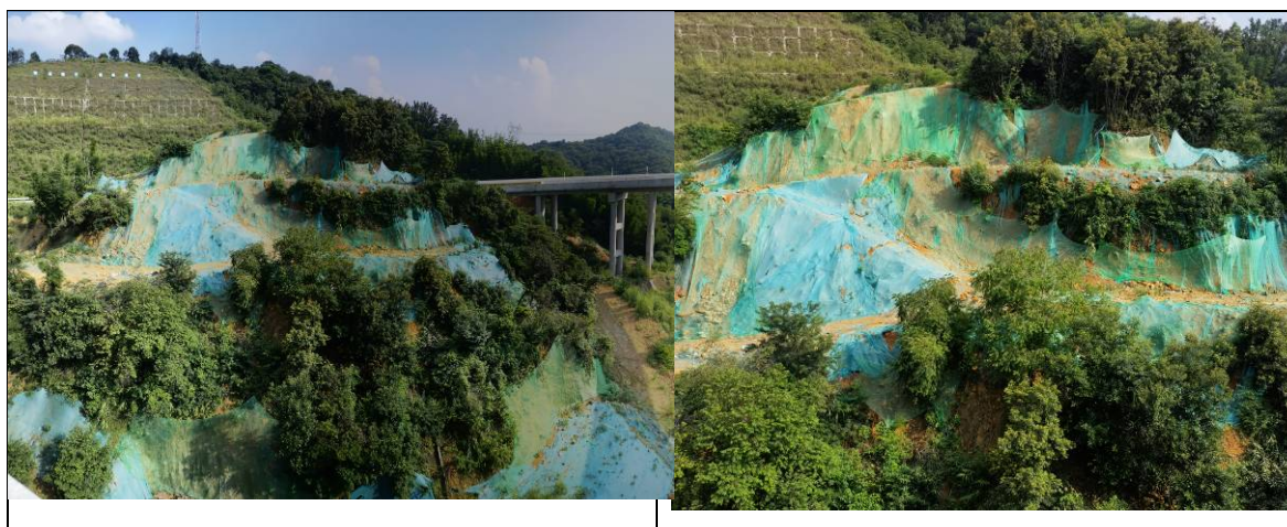
图 7-1 遗留工程临时苫盖现状
