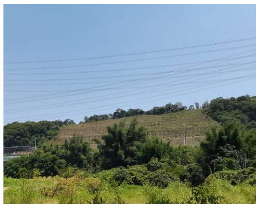
路基挖方边坡防护
