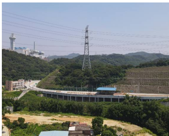
A 匝道及边坡现状 1
