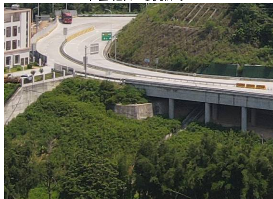
桥头挡墙支护
