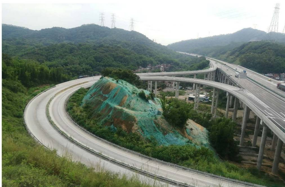
山体裸露，存在水土流失隐患
