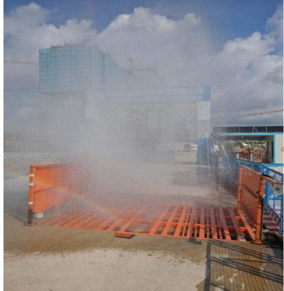
施工期间内外通道硬底化，出入口设洗车场地
