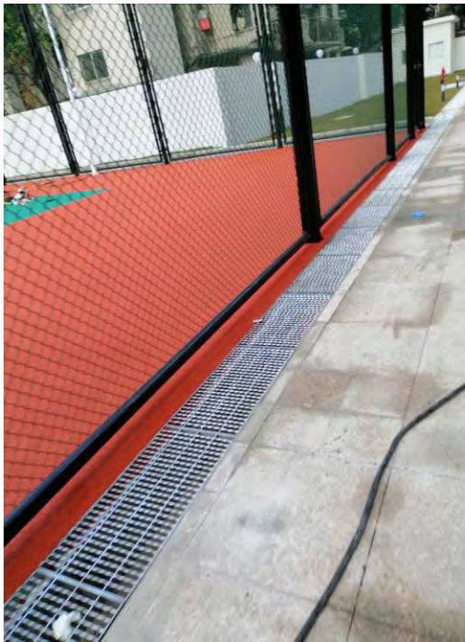
项目区内排水沟
