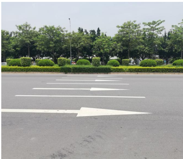
道路工程现状
