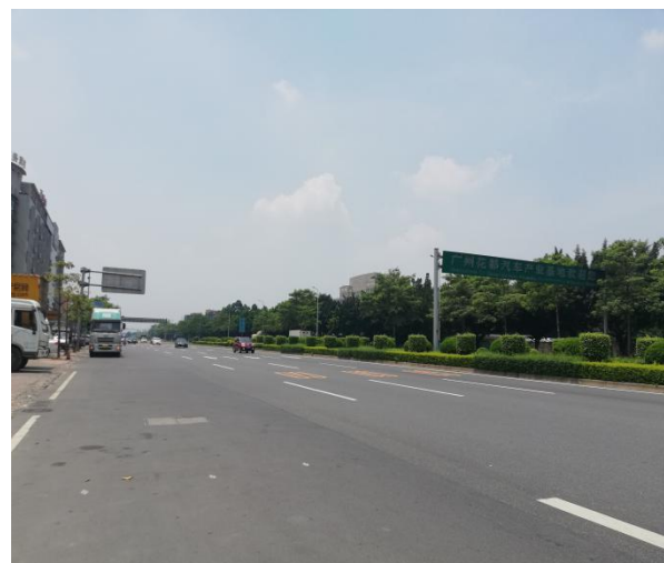
道路工程现状
