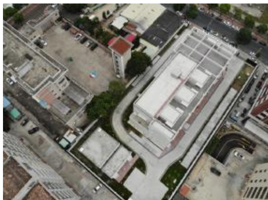
图 1-2 变电站监测点
