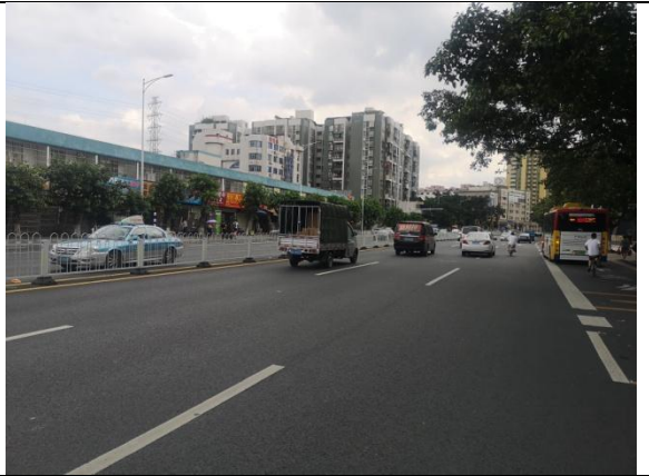
道路终点现状
