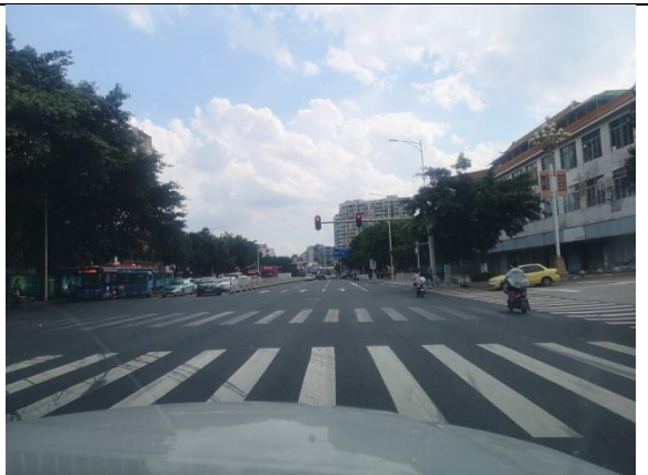
道路起点现状
