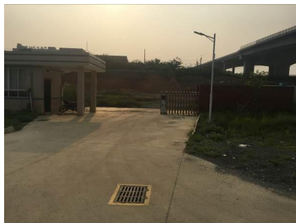
厂区出入口现状
