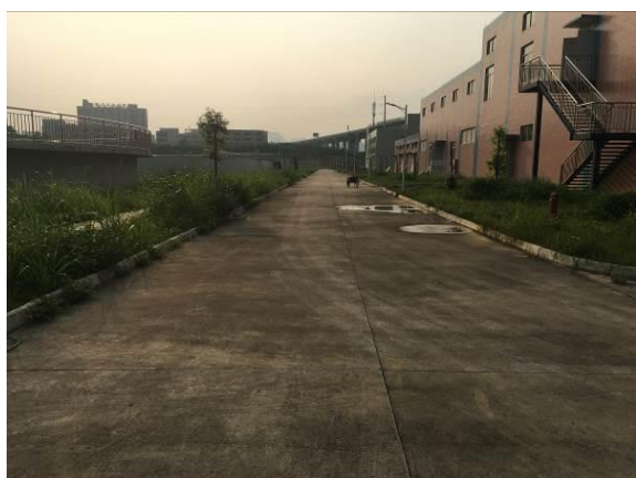
道路区硬化现状 1
