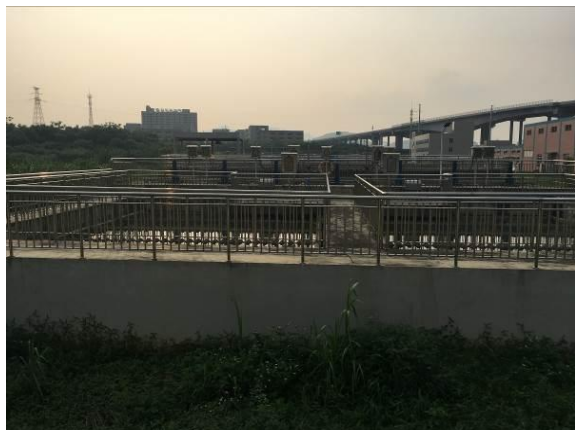
近期（首期 2 万 \text{m}^3/\text{d} ）工程生产区现状 1
