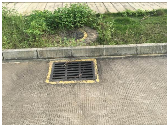
区内雨水管网现状 1
