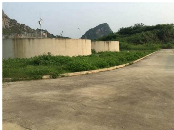
近期（首期 2 万 \text{m}^3/\text{d} ）工程生产区现状 2
