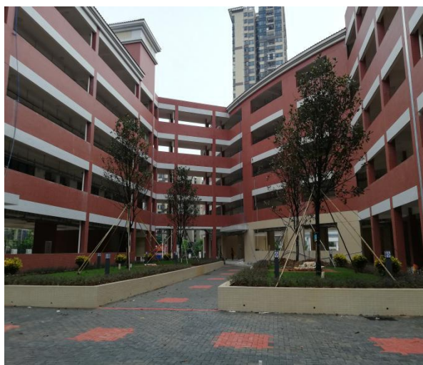
主体建筑物现状
