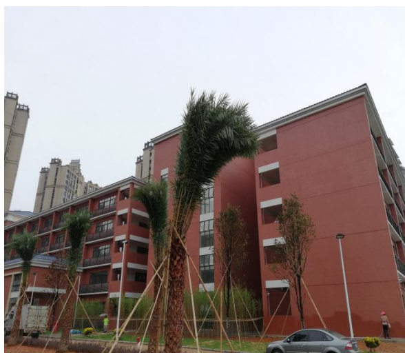
主体建筑物现状
