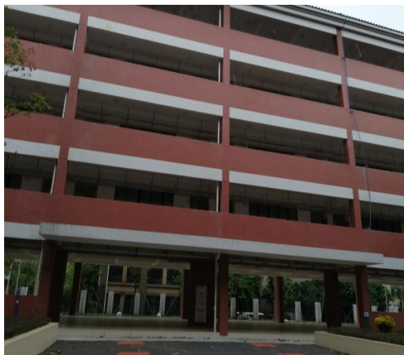
主体建筑物现状
