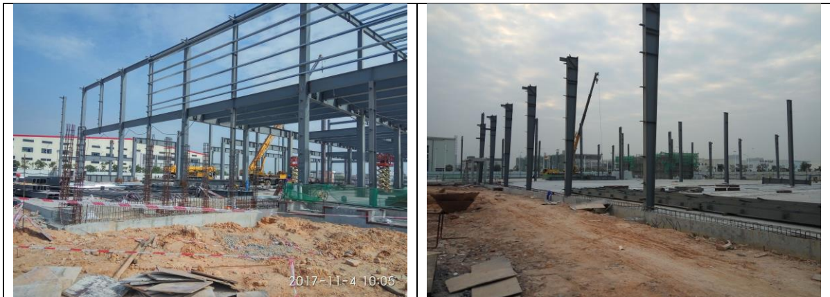
厂房建设情况
