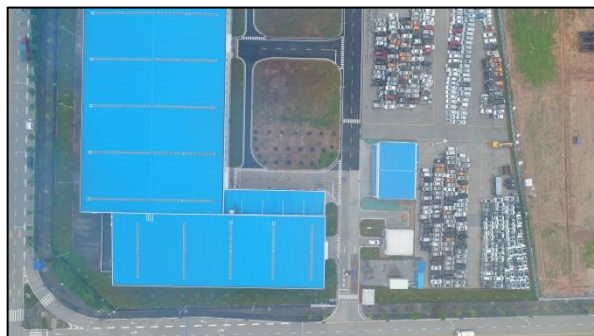
图 2 项目西部现状正射影像图
