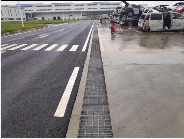
图 8 废旧车辆存放区北侧排水沟现状
