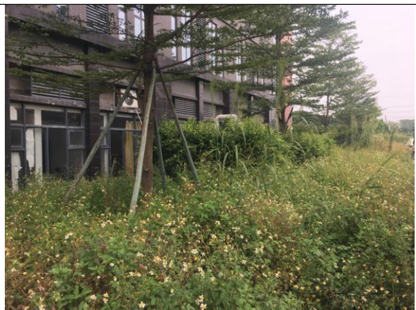
10、项目东侧红线外绿化现状
