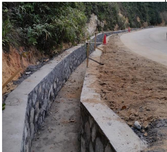
图 2 项目排水沟施工
