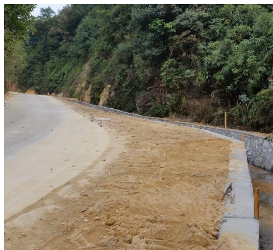
图 1 项目路面施工
