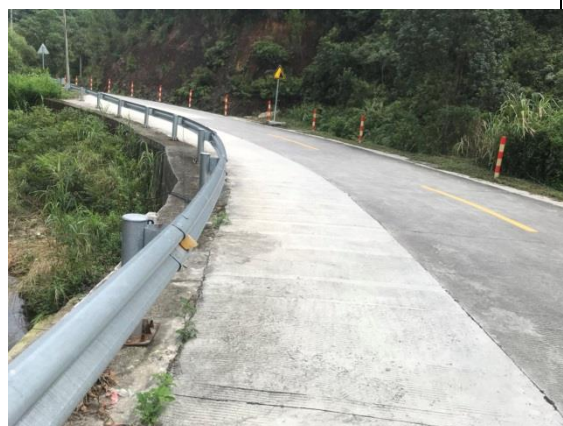
图 3 项目修复后路面
