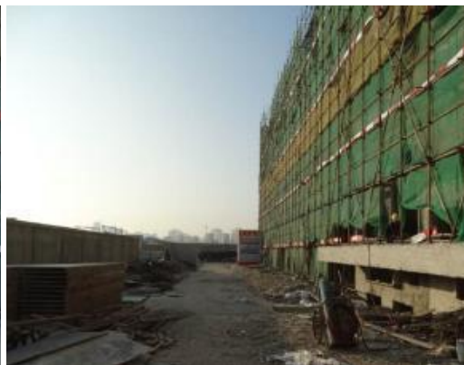
图 1-2 变电站南侧现状
