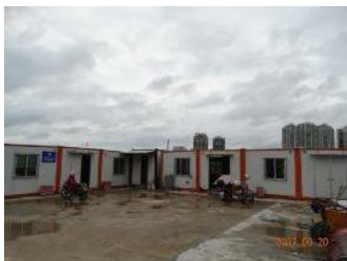
图 3-3 施工营地现状
