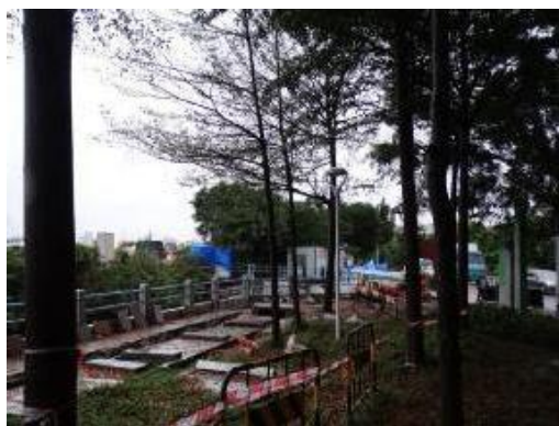
图 4-3 电缆沟施工现状
