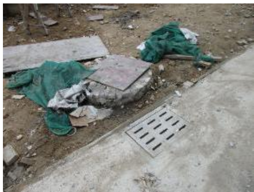
图 2-3 变电站南侧雨水口
