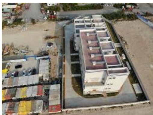
图 6-3 变电站西侧现状
