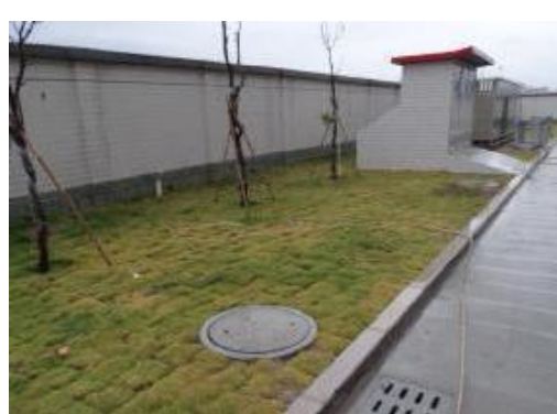
图 4-6 变电站南侧覆绿情况
