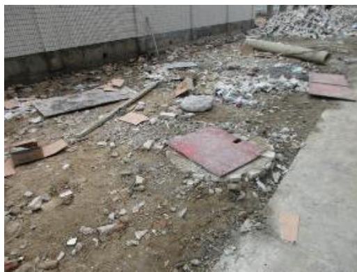
图 2-4 变电站南侧雨水检查井
