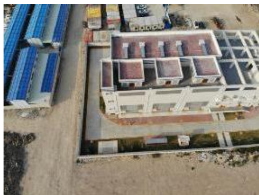
图 6-2 变电站北侧现状
