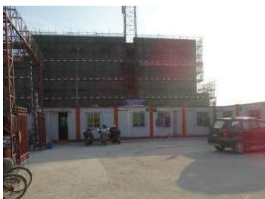
图 1-3 施工营地现状
