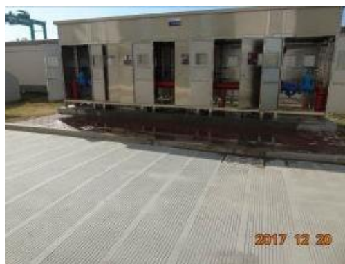
图 5-2 变电站东侧现状
