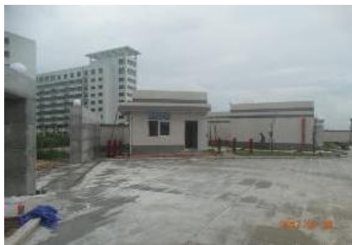
图 3-1 变电站进出口现状
