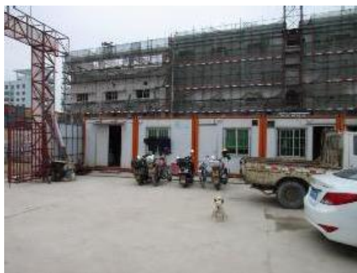
图 2-6 施工营地现状
