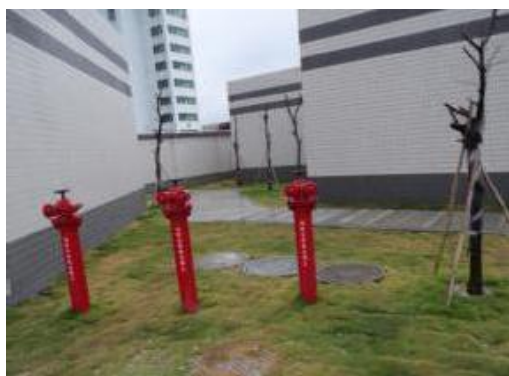
图 4-5 变电站东侧覆绿情况
