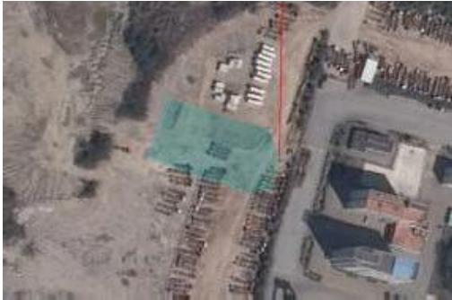
图 1 2016 年 3 月情况 (变电站)
