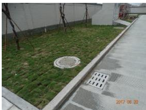
图 3-5 变电站南侧雨水口
