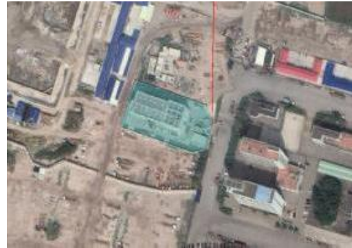
图 4 2018 年 6 月情况 (变电站)
