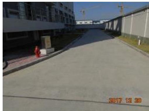
图 6 2017 年 12 月情况 (变电站)
