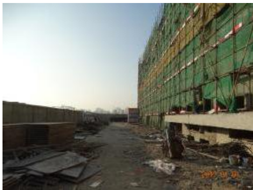
图 5 2017 年 1 月情况 (变电站)
