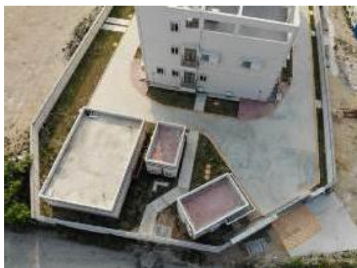
图 7-1 变电站东侧现状
