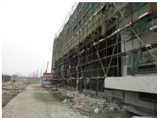
图 2-1 变电站南侧现状
