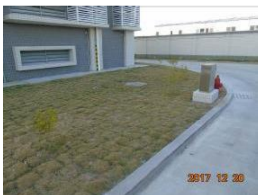
图 5-5 变电站东侧覆绿情况
