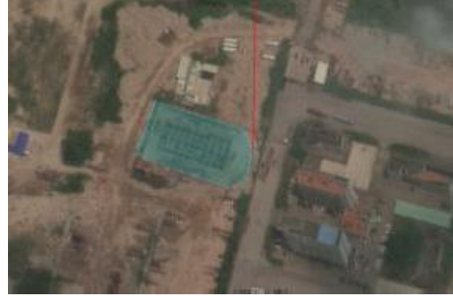
图 2 2016 年 8 月情况 (变电站)
