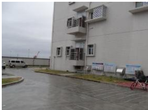
图 4-2 变电站东侧现状
