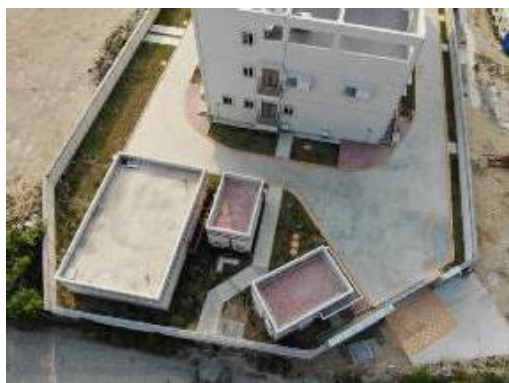
图 6-1 变电站东侧现状
