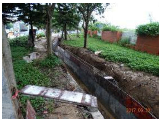
图 3-4 电缆沟施工现状
