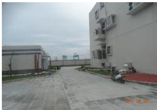
图 3-2 变电站东侧现状
