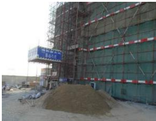
图 1-1 变电站东侧现状
