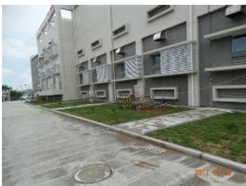
图 3-6 变电站北侧雨水检查井
