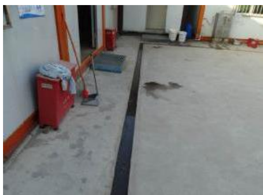
图 1-5 施工营地临时排水沟
