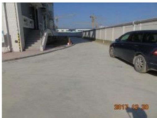
图 5-1 变电站南侧现状
