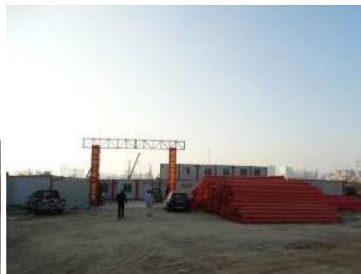
图 1-4 施工营地现状
