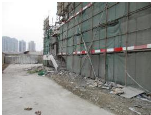
图 2-2 变电站西侧现状
