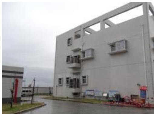
图 4-1 变电站东侧现状
