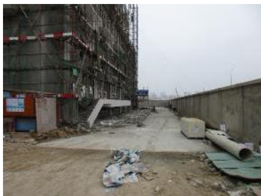
图 2-5 变电站北侧现状
