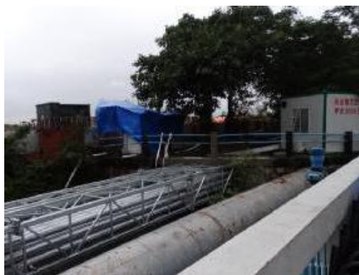
图 4-4 电缆沟施工现状
