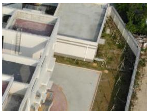
图 6-5 变电站南侧覆绿情况
