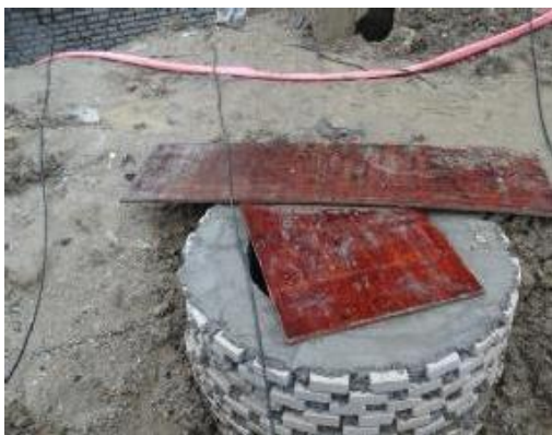
图 2-7 变电站南侧雨水检查井
