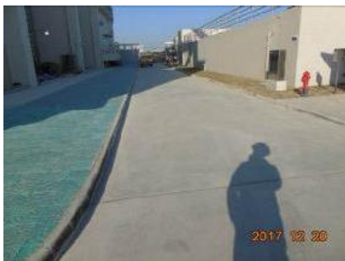
图 3-1 变电站南侧情况
