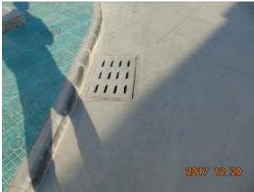
图 3-7 变电站南侧雨水口
