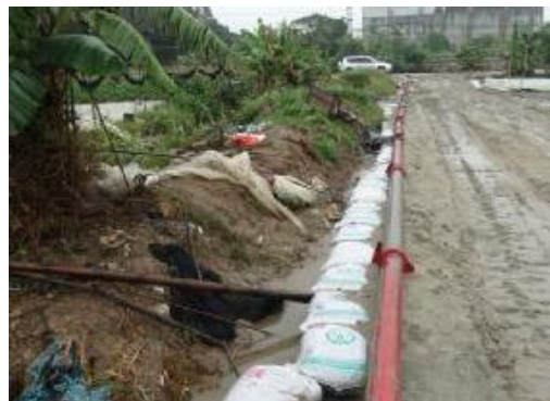
图 2-12 塔基区临时排水沟
