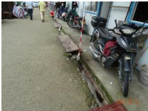
图 1-7 施工营地临时排水沟
