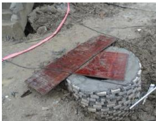
图 2-8 变电站南侧雨水检查井
