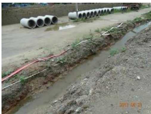
图 1-9 变电站西侧临时排水沟
