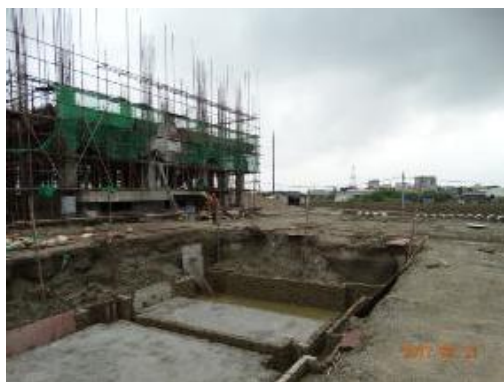
图 1-4 变电站北侧情况
