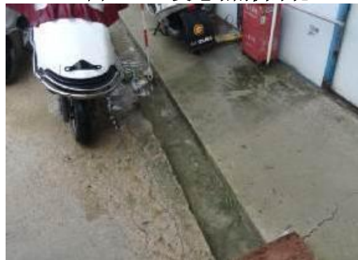
图 3-12 施工营地临时排水沟
