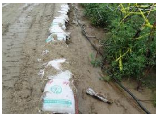
图 2-11 塔基区临时拦挡
