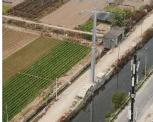
图 1-5 3#塔监测点 (监测道路恢复情况)
