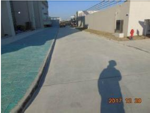
图 3 变电站 2017 年第 4 季度情况
