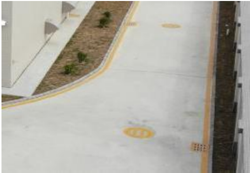
图 1-3 变电站监测点 (监测排水情况)
