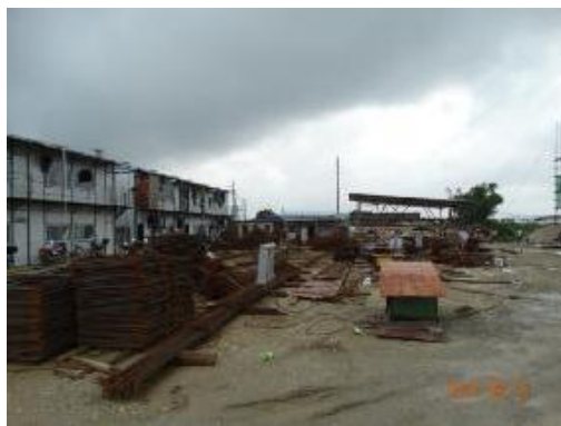
图 1-2 变电站南侧材料堆放区域情况
