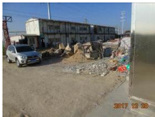
图 3-2 变电站南侧施工营地区域情况
