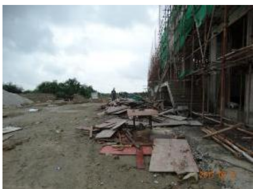
图 1-5 变电站北侧情况
