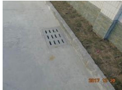
图 3-8 变电站南侧雨水口
