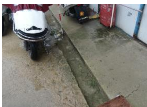
图 2-9 施工营地临时排水沟
