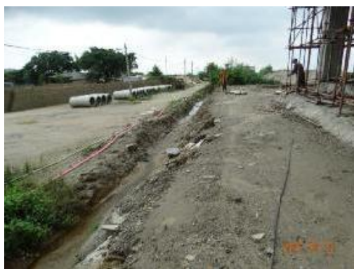
图 1-10 变电站西侧临时排水沟
