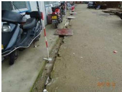
图 1-8 施工营地临时排水沟
