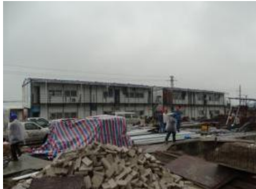
图 2-4 变电站南侧施工营地情况
