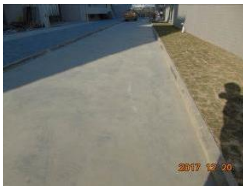
图 3-9 变电站南侧绿化
