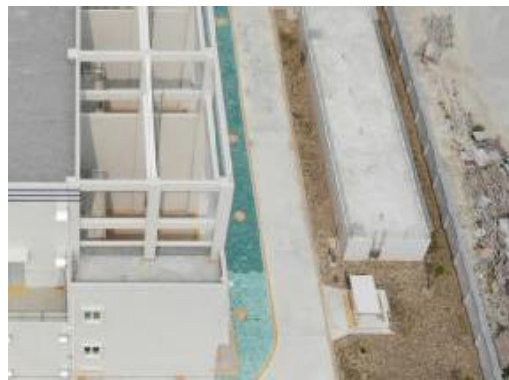
图 4 变电站 2018 年第 1 季度情况
