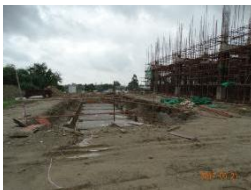
图 1-6 变电站北侧情况
