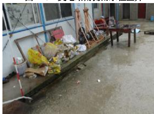
图 2-10 施工营地临时排水沟
