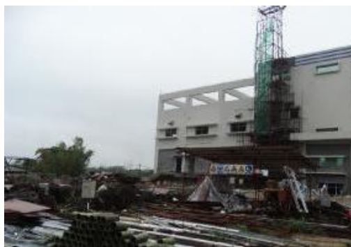
图 2-2 变电站南侧材料堆放区域情况
