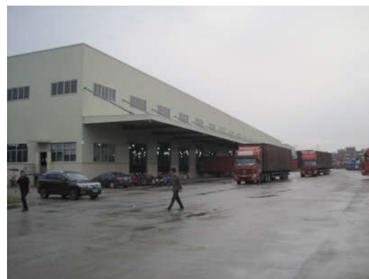
照片 6 厂区现状
