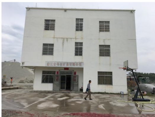
图 7 :生活区办公楼现状
