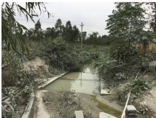
图 5:工业场地沉沙池现状
