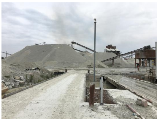
图 3：工业场地区现状
