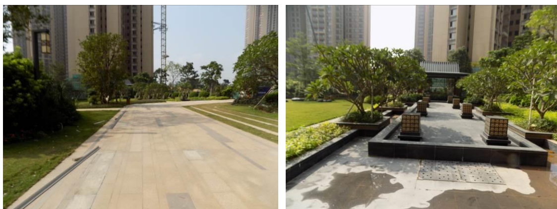
区内道路现状
