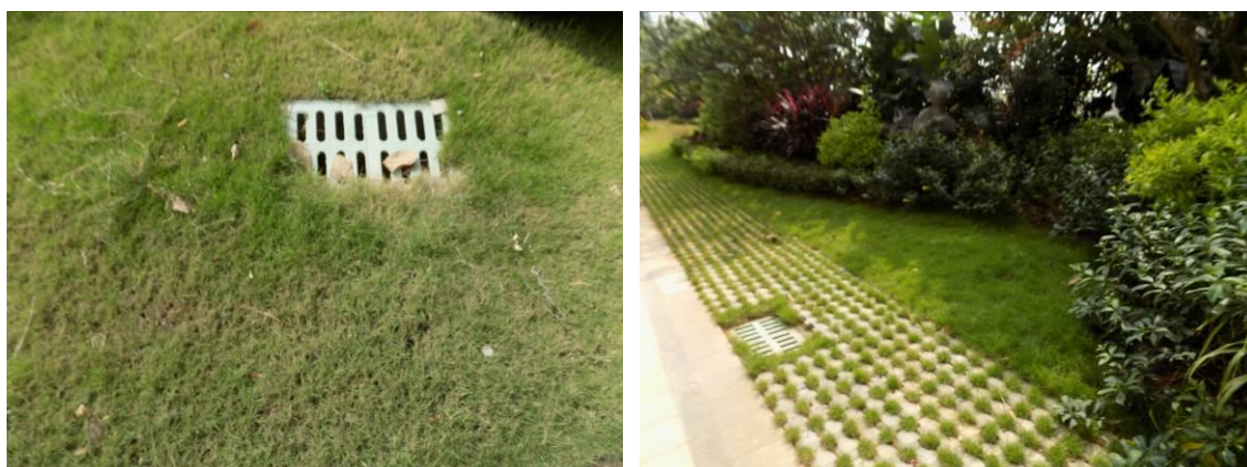
雨水管网现状
